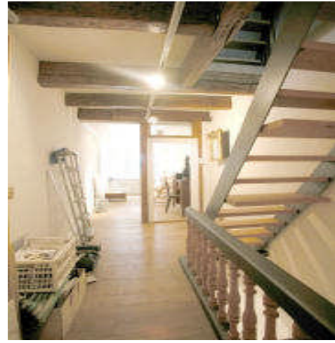
Wegfall Innenwand – neuer Durchblick
