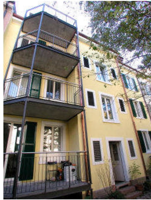
Fassadensanierung mit Balkonanbau
