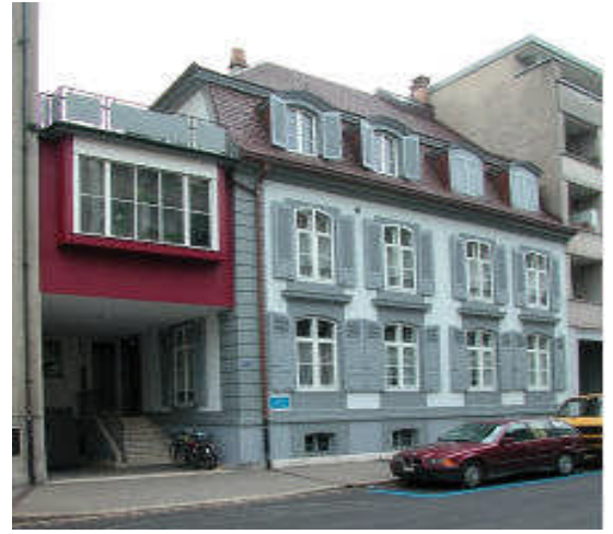
Fassaden- und Dachsanierung
