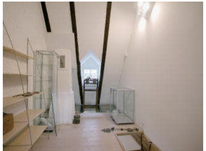
Einbau Dachgaube und innere Verkleidung
