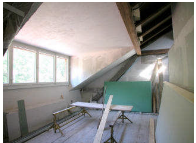
Innere Verkleidung Ausbau
